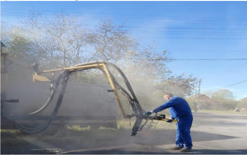
Rysunek 4. Remont drogi.
