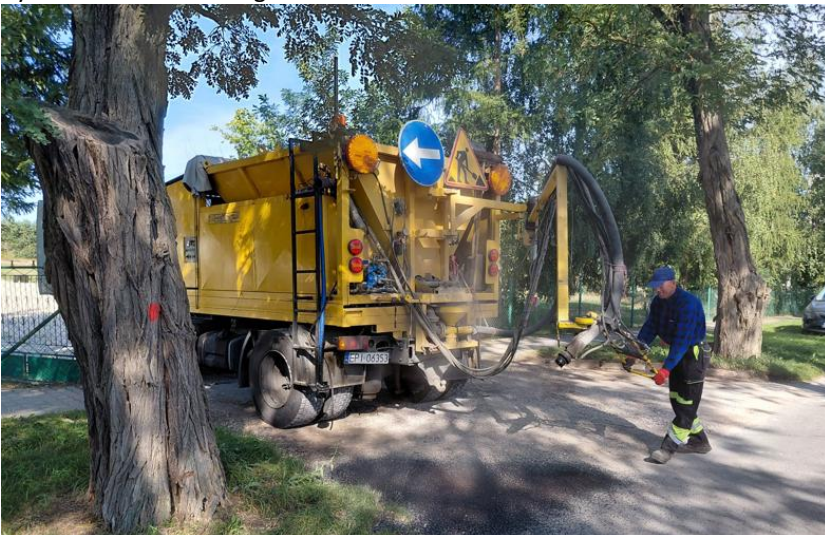
Rysunek 5. Remont drogi.
