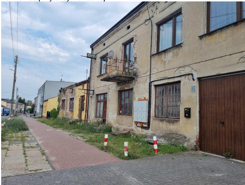
Fotografia 30. Kamienice przy ulicy Koneckiej
