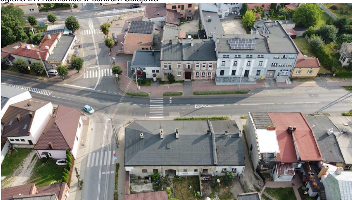
Fotografia 27. Kamienice w centrum Sulejowa
