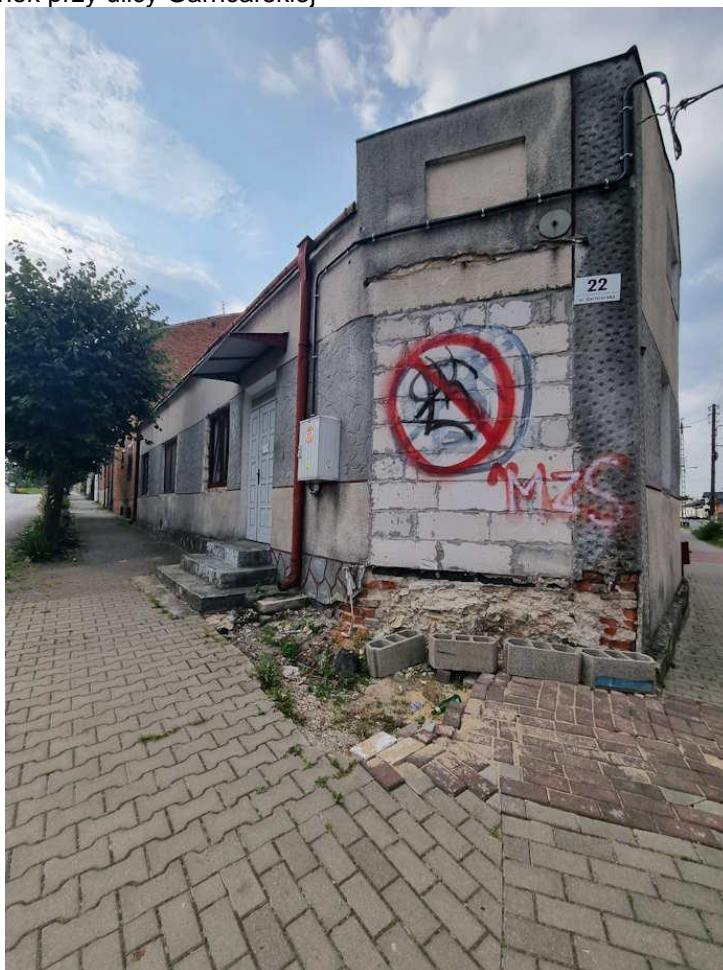
Fotografia 24. Budynek przy ulicy Garncarskiej
