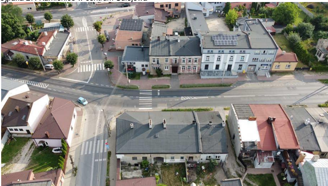
Fotografia 27. Kamienice w centrum Sulejowa
