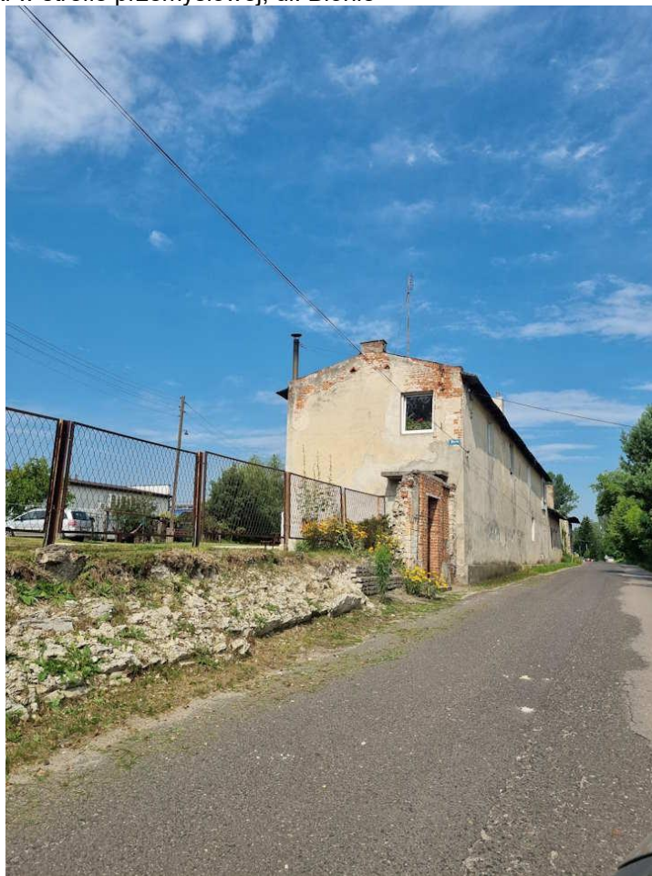
Fotografia 5. Budynki w strefie przemysłowej, ul. Błonie
