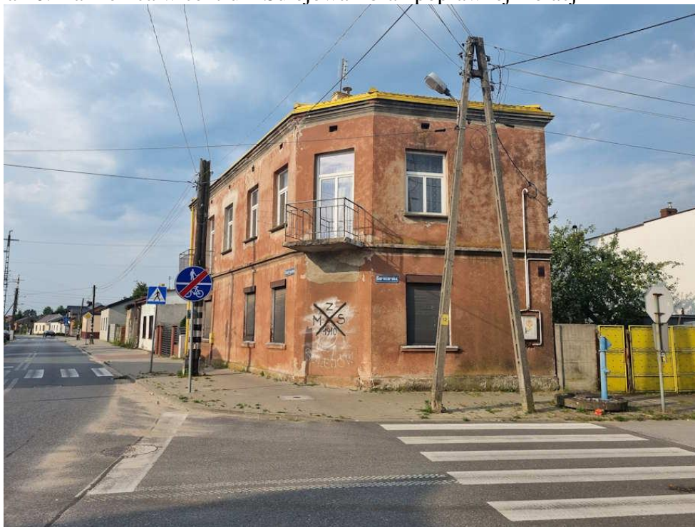
Fotografia 10. Kamienica w centrum Sulejowa - brak poprawnej izolacji
