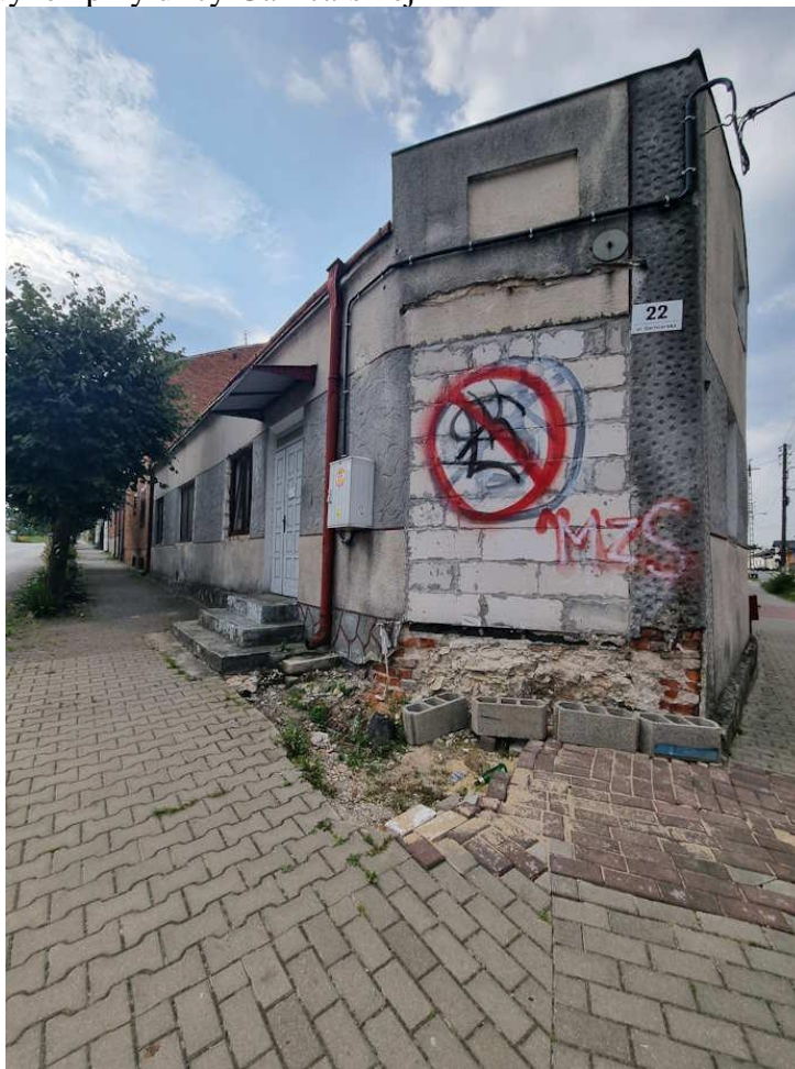
Fotografia 22. Budynek przy ulicy Garncarskiej
