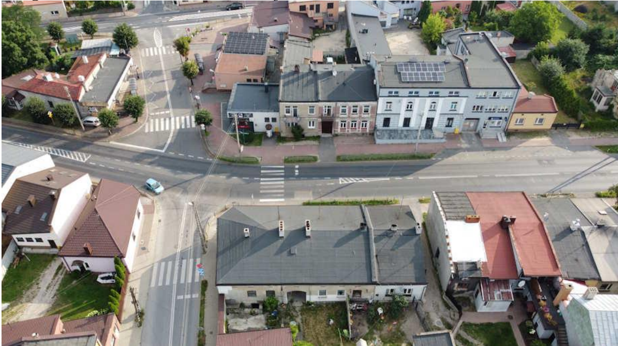
Fotografia 25. Kamienice w centrum Sulejowa
