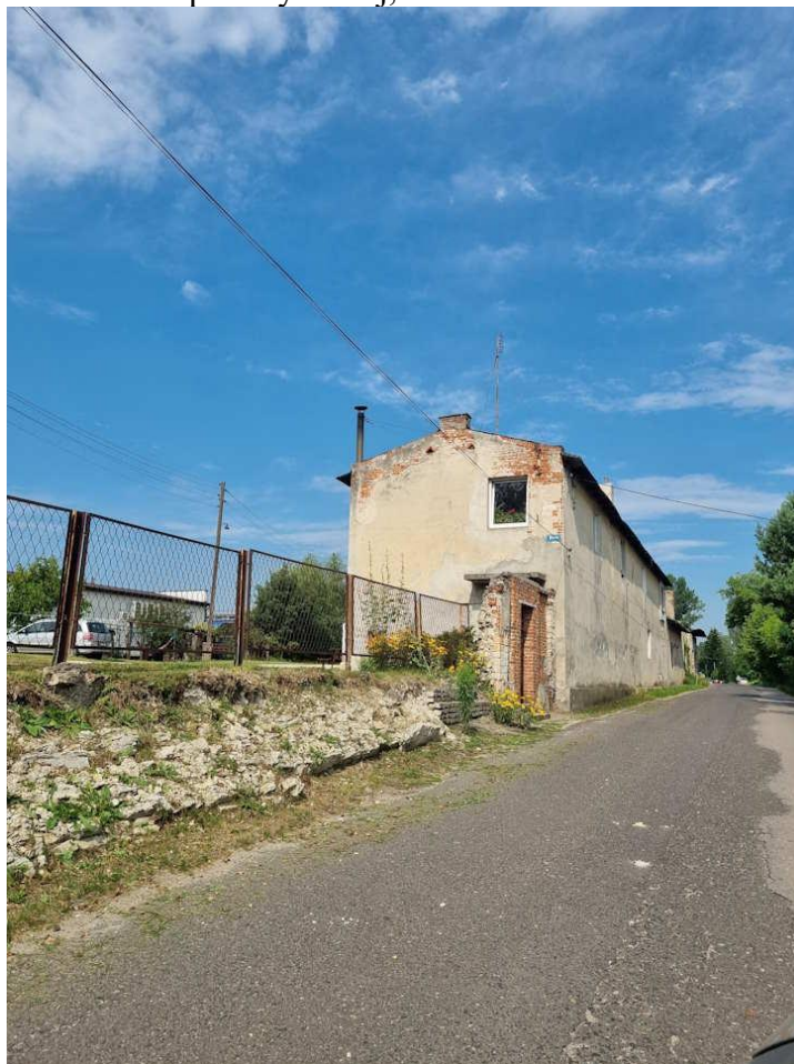
Fotografia 3. Budynki w strefie przemysłowej, ul. Błonie
